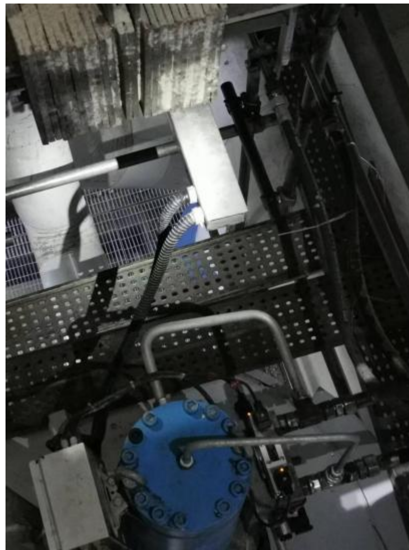
高压油泵阀门油品泄露火灾隐患极早期发现
